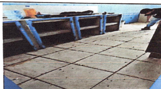
Foto 6: Piso durante la remodelación
