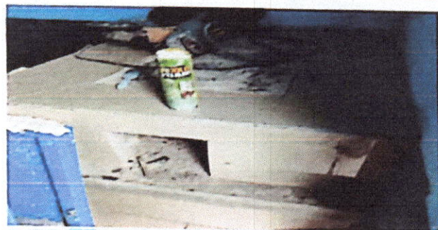
Foto 3: Plancha durante la remodelación
